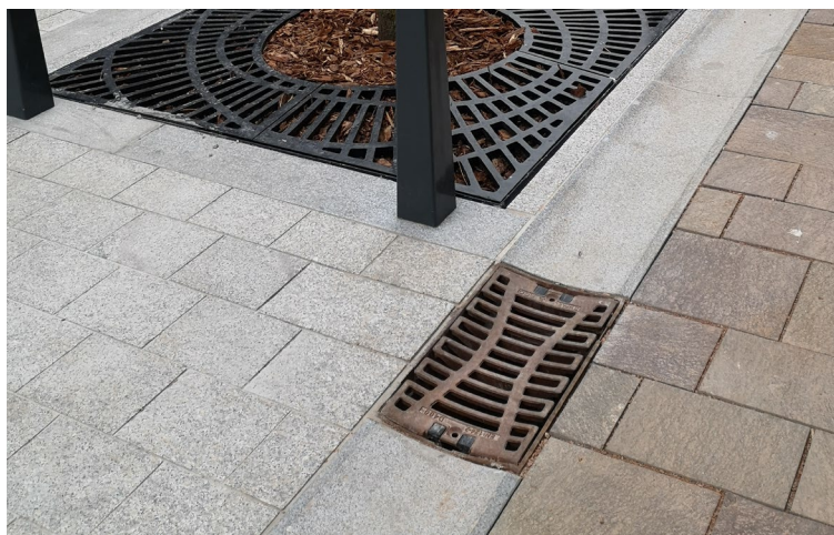
Faveremrác és vízelosztó-levegőztető kút beépítés után.
